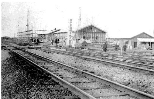
【↑写真上】建設中の日本麦酒鋳泉(株)東京工場（大正）
