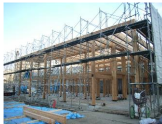
【←写真左】 アトリアの建設風景。木造(集成材)でその床はサッポロビール工場の基礎松杭を製材し使われている。
